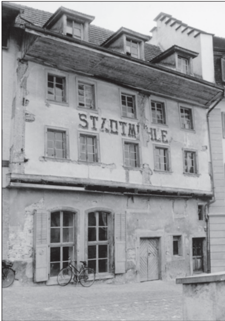
Die Stadtmühle vor der Renovation.
